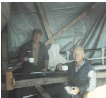
Kabelskøyting på Føyno.
