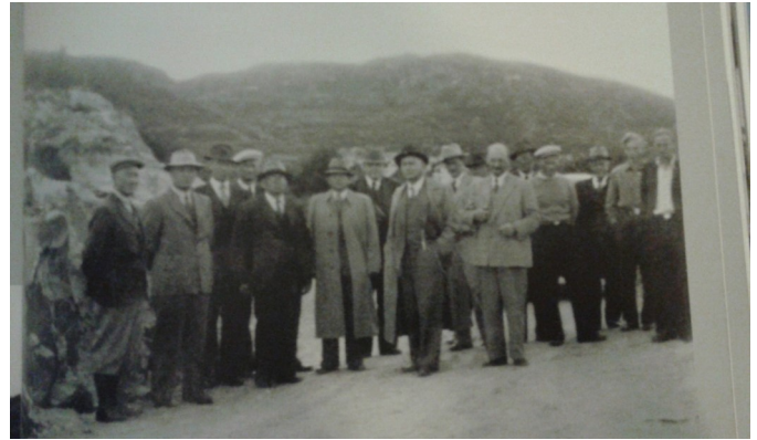
Det var større mannskap for å åpne veien enn det var for å bygge den.
